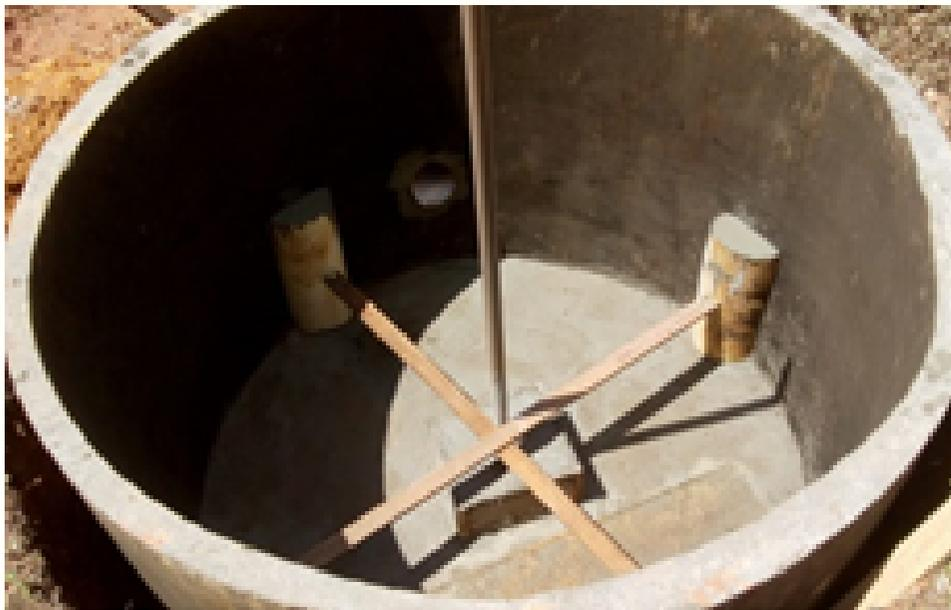
Apoiar com um sarrafo ou qualquer outro objeto os 4 suportes limitadores da caixa de plástico de 1500 litros. Os suportes limitadores também podem ser feitos de tijolo furado ou bloco.
