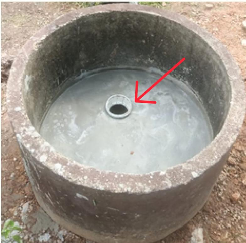
OBS: O cano de 100mm de 1,2m de comprimento servirá para unir os dois joelhos e dar passagem ao esterco verde que será conduzido até o fundo da caixa de fermentação.
