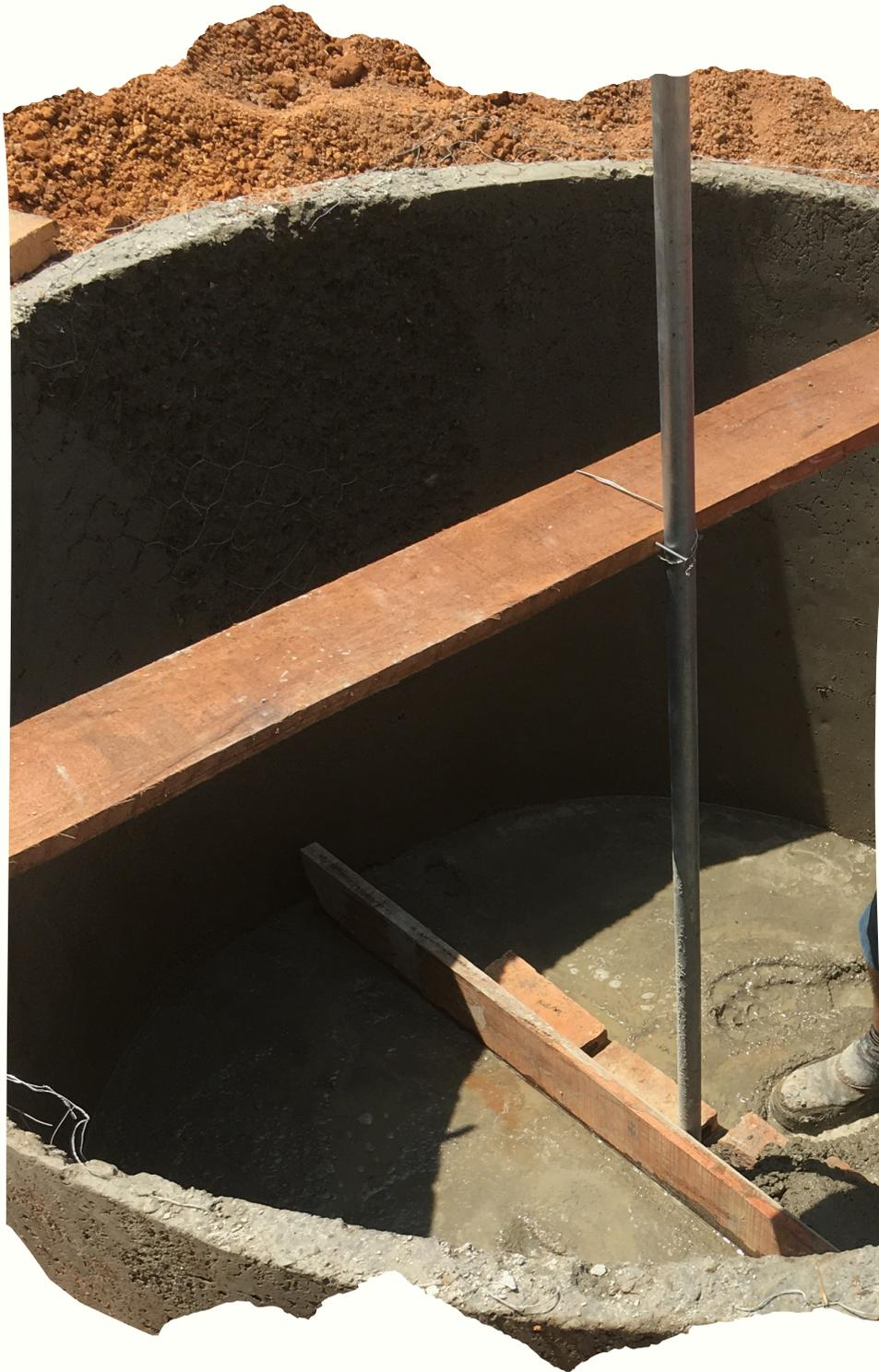
Depois da instalação do tubo de alimentação e do tubo descarga, encontre o centro da base da caixa de fermentação. Faça uma escavação de 80cm de profundidade por 15cm de largura. Em seguida coloque, de forma centralizada e aprumada, a barra de ferro de 25mm de diâmetro e 3m de comprimento. E finalmente preencha com concreto este buraco.
