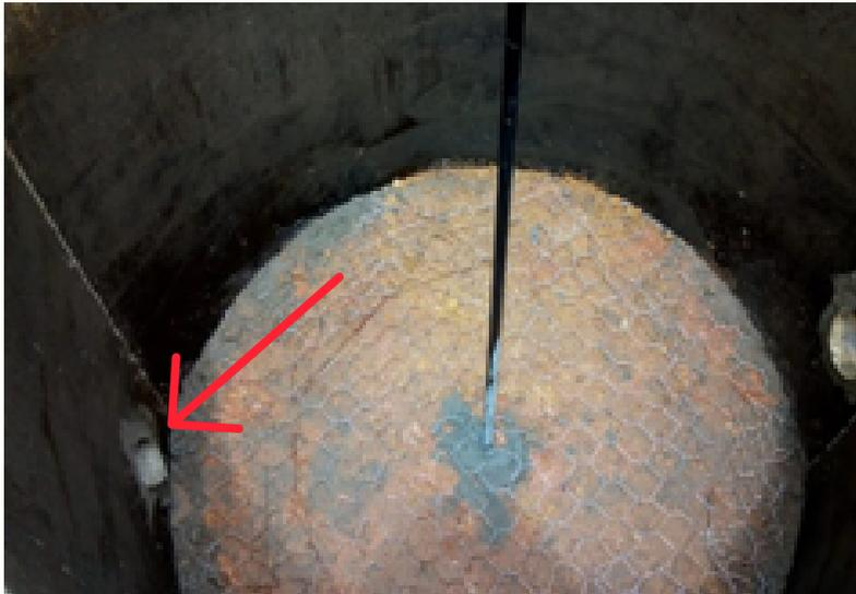
Você precisará de 2 joelhos de 100mm de 45 graus, 1 para a base da manilha que será concretada (conforme figura ao lado) e outro para aquele buraco feito a 25cm de altura na caixa de fermentação.
