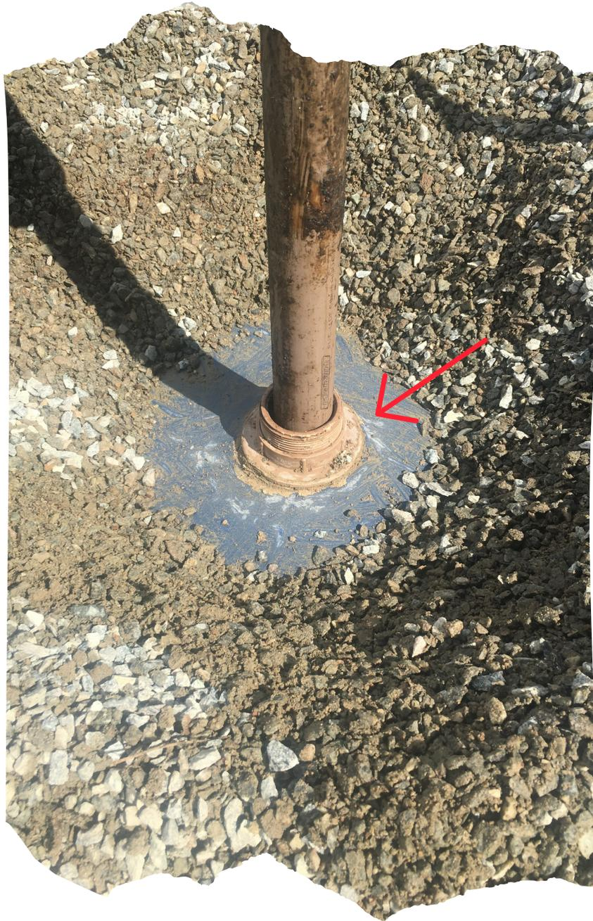
Verificar se tem algum vazamento na flange guia, aquela que fica no centro do biodigestor.
